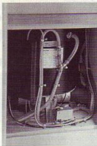
**Nova Trumina peč in vodni grelnik v enem sta spravljena za vrati omarice, pod garderobno omaro.**
